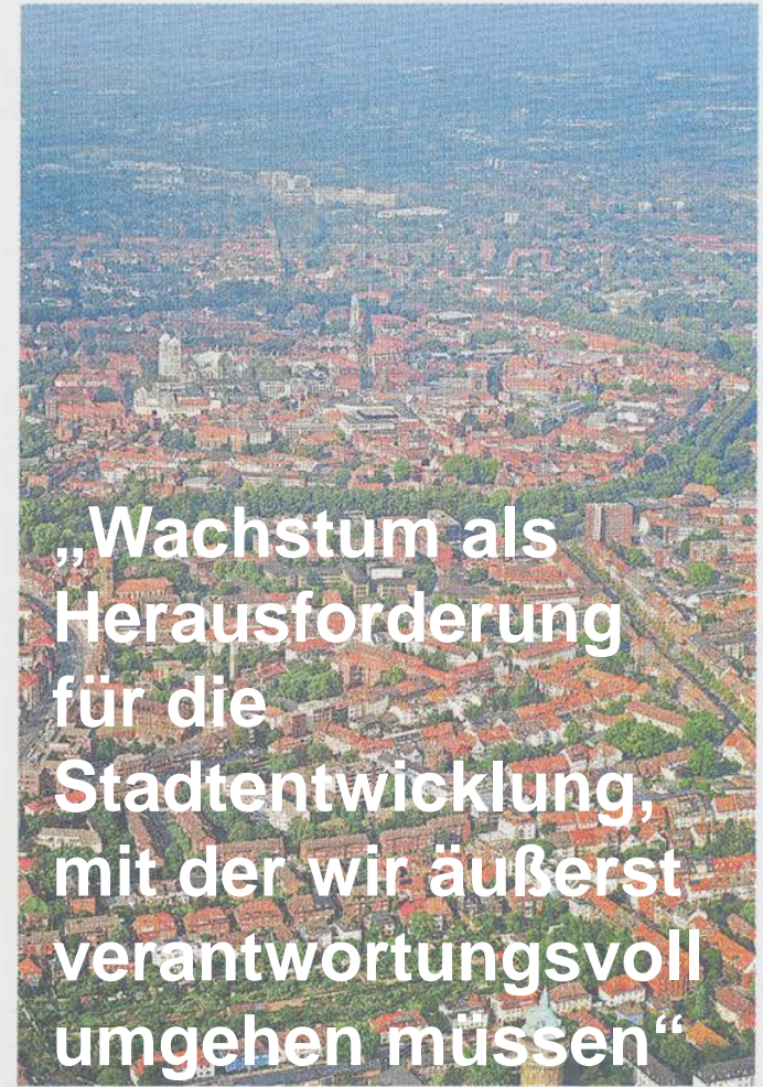
Münster wächst weiter: Ende vergangenen Jahres waren hier 298 518 Bürger gemeldet. Foto: Luftbildkontor Fischer
